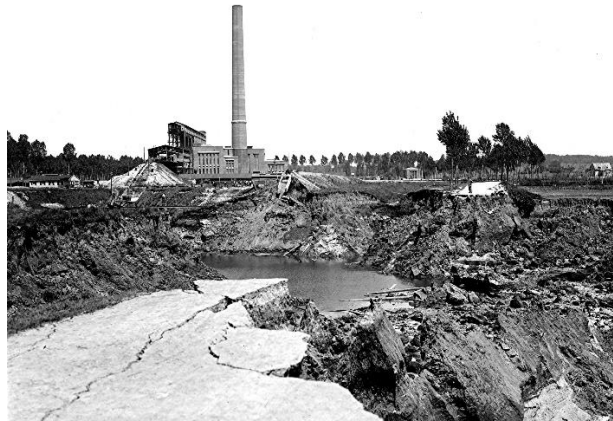
Bild 4 a: Wassereinbruch der Erft und Überflutung der Grube im Jahre 1926. 6
