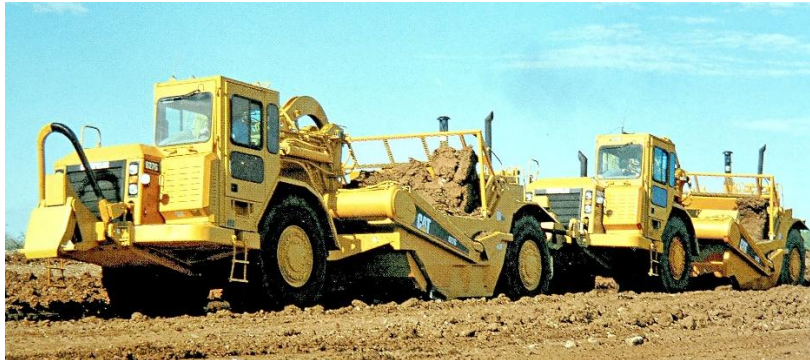
Bild 9: Schürfzüge 9 bei den Erdbauarbeiten für das Kraftwerk 2 in Frimmersdorf
