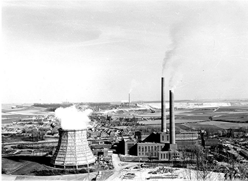
Bild 6: Kraftwerk Frimmersdorf 1 nach Kapazitätserweiterung auf 90 MW im Jahre 1950 mit zweitem Schornstein und dem Bischof-Kühlturm, im Hintergrund die Brikettfabrik Prinzessin Viktoria in Neurath
