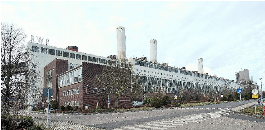
Bild 17: Die Kraftwerksfront parallel zur Straße zwischen Frimmersdorf und Neuenhausen (Energierstraße) im Jahr 2024
