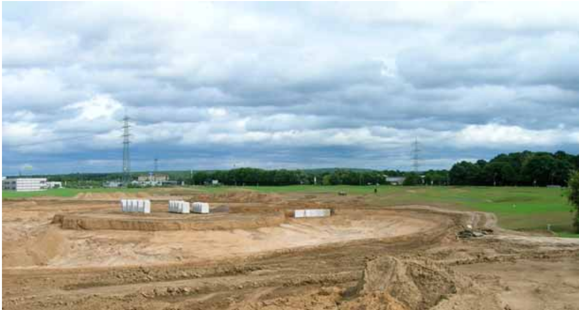
Bild 15: Bau der Spielbahn 9: Die Ausschachtungen für den späteren See sind fertig, rechts sind schon die begrünten Flächen des Kurzspielareals zu erkennen. 14
