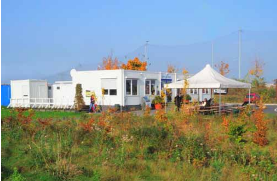
Bild 25: Provisorische Zwischenlösung mit modular aufgebauten Raumsystemen; In den blauen Containern (links) lagern Betriebsmittel und Gerätschaften der Greenkeeper.
