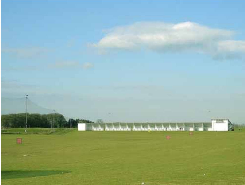
Bild 18.2: Abschlagkabinen an der Driving Range
