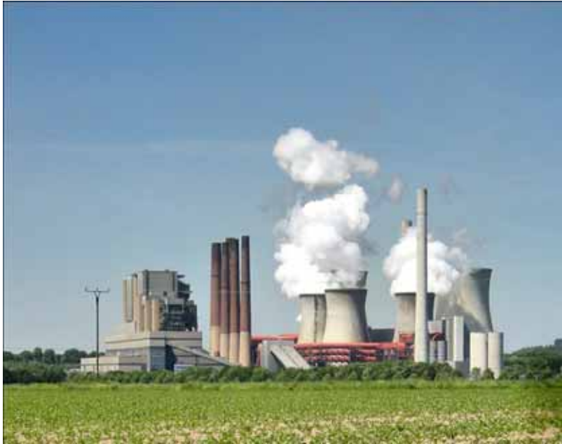
Bild 7: Braunkohlekraftwerk Neurath am Standort der ehemaligen Brikettfabrik Neurath. Es ging 1972 in Betrieb.
