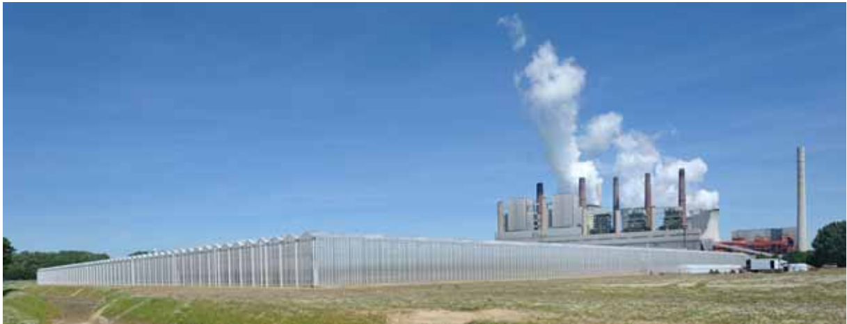
Bild 15: Gewächshaus für den Anbau von Rispentomaten in Neurath. Es wird mit Fernwärme aus dem Braunkohlekraftwerk Neurath beheizt.
