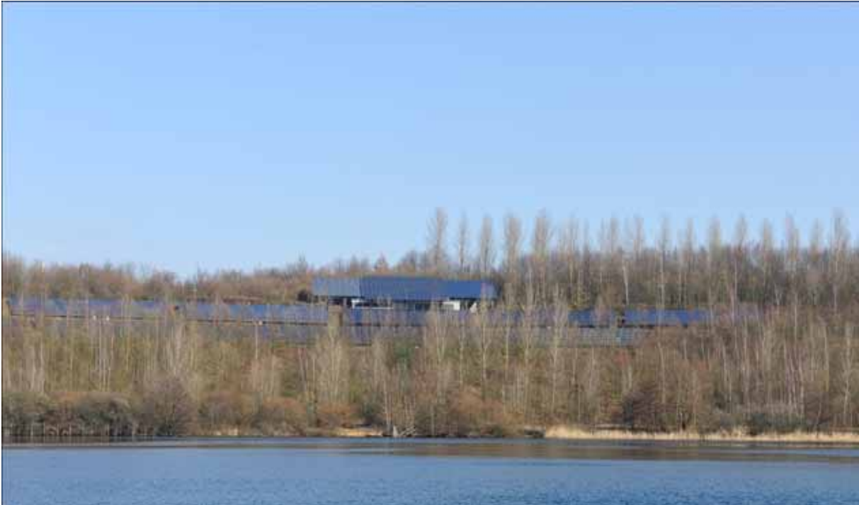
Bild 12: Fotovoltaikanlage an der Böschung des Neurather Sees. Der See entstand im Zuge der Wiedernutzbarmachung des an dieser Stelle ehemals betriebenen Tagebaus Neurath-Nord.
