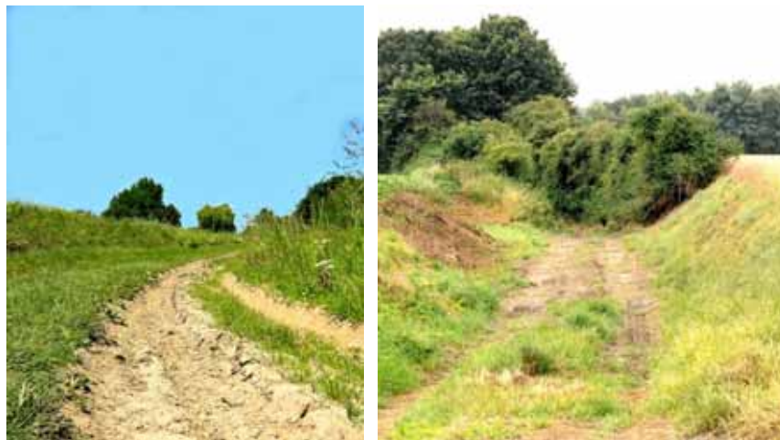
Bild 2: Typische Hohlwege in der Lösslandschaft über die Wasser von der Hochfläche in das Dorf Neurath abfloss 2
