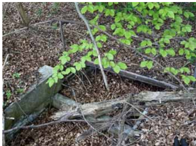
Bild 13: Einlaufbauwerk des alten Klärteichs
