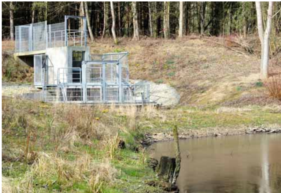
Bild 9: Auslaufbauwerk am südwestlichen Ende des Kraftwerksteiches
