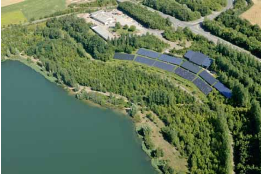
Bild 23: Photovoltaikanlage am Nordrand des Neurather Sees, links daneben ein Betriebshof der Stadt Grevenbroich
