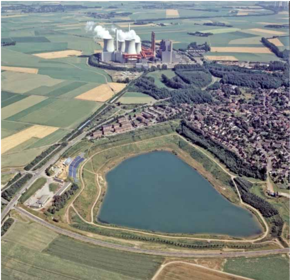
Bild 22: Der Neurather See, rechts Neurath, oben im Bild das Kraftwerk Neurath 1 34 An der Nordseite des Neurather Sees wird eine Photovoltaikanlage betrieben. Daneben hat die Stadt Grevenbroich einen Betriebshof.
