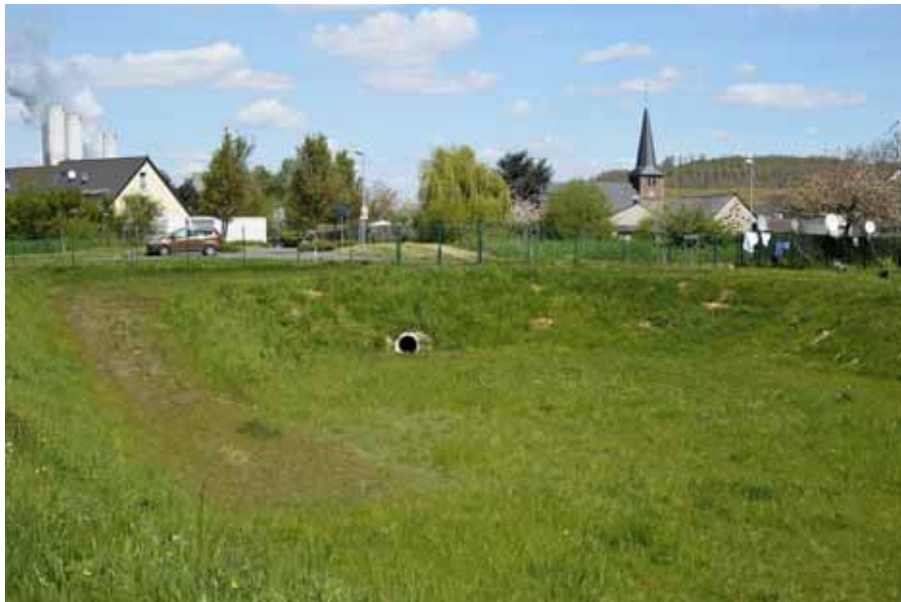
Bild 20: Regenrückhaltebecken im Nebenschluss zum Graben Am Glockenstrauch
