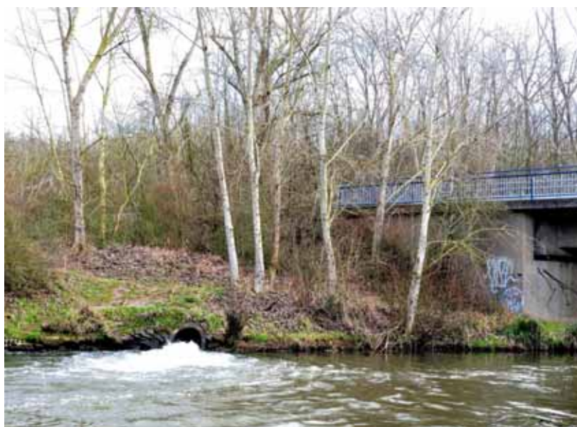
Bild11: Mündung des Haldenfußbaches in die Erft nördlich der K 39
