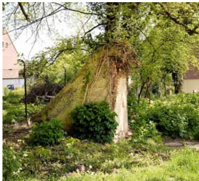
Bild 7: Luftschutzbunker in der heutigen Erftstraße in Frimmersdorf, kurz vor der Erftbrücke.
