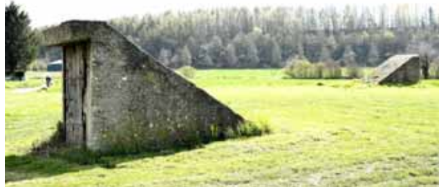
Bild 6: Luftschutzbunker in Frimmersdorf an der Kauler Hüll
