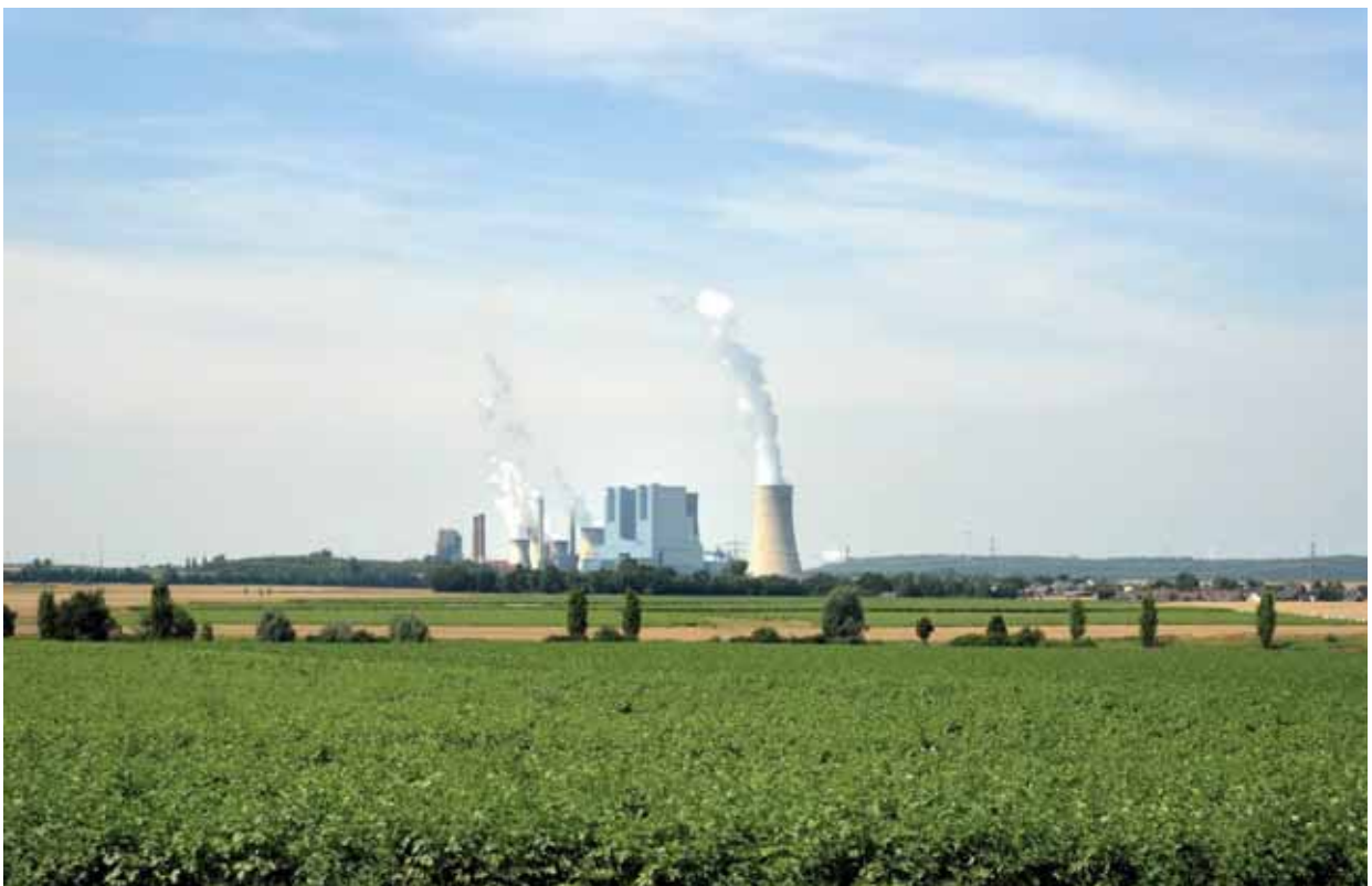
Tagebau Fortuna, Kraftwerk Neurath
